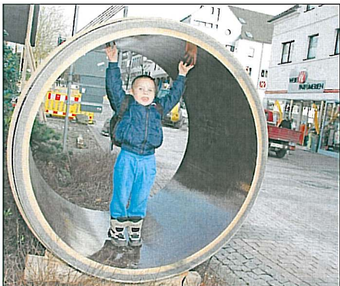
Da muss sich der vierjährige Hendrik schon ganz schön recken: 120 Zentimeter messen die Kanalrohre im Durchmesser, die in der Langen Straße verbaut werden. Er ist 1,04 Meter groß. Foto: Jürgen Köster
